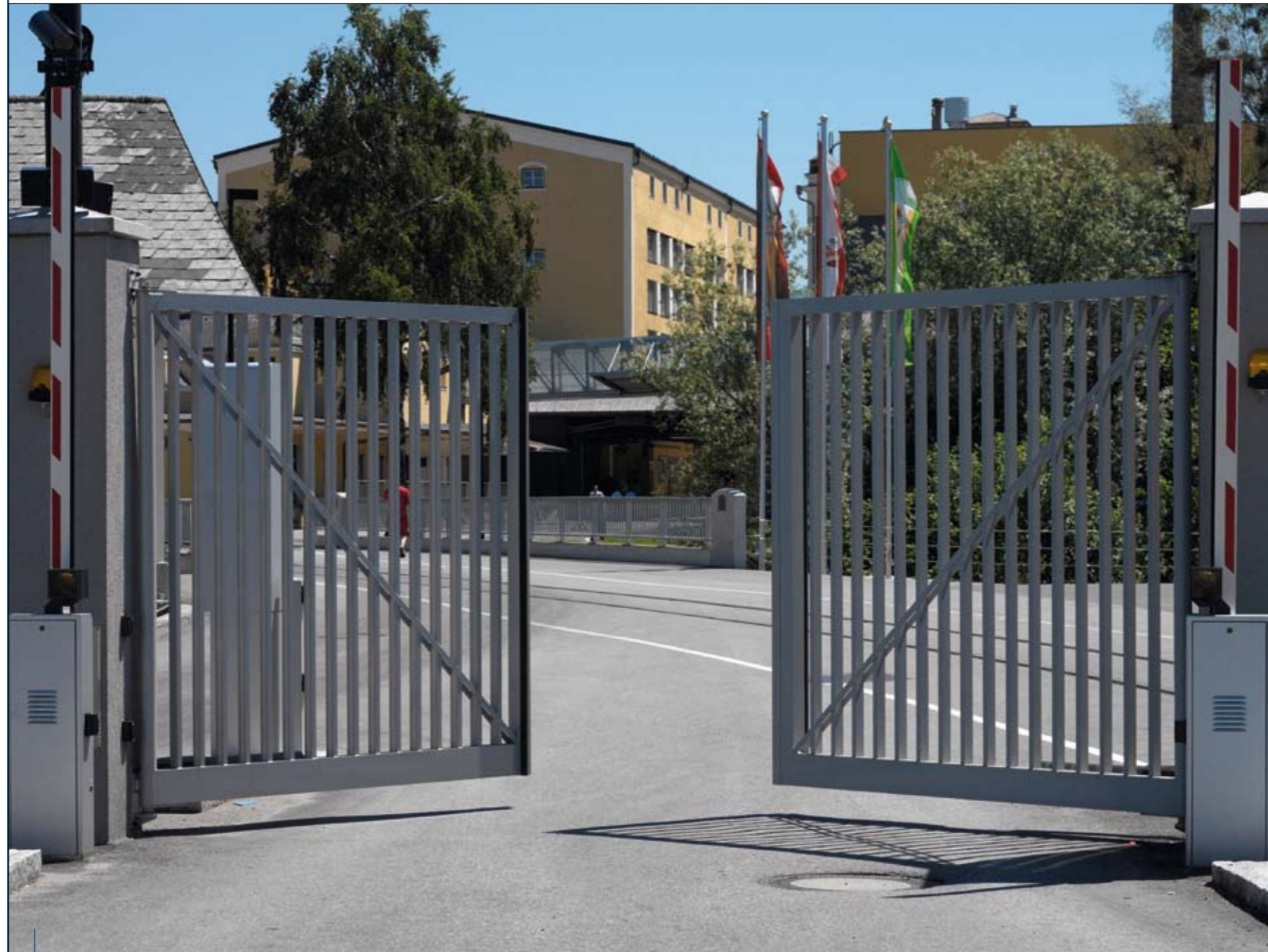
Automatisches, zweiflügeliges Drehtor mit Zugbändern in den Torflügeln, Höhe 2,5 m
