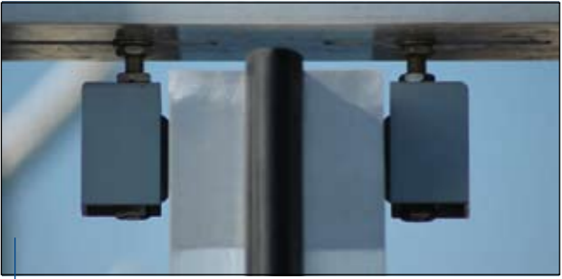
Eingreifschutz bei Führungsrollen
