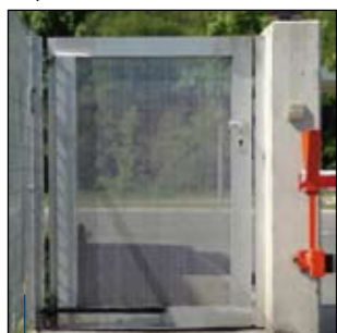
Gehtüre mit Lochblechfü- lung, mit Rohrtürschließer
