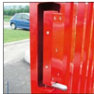
Bodenriegel in Standflügel eingebaut
