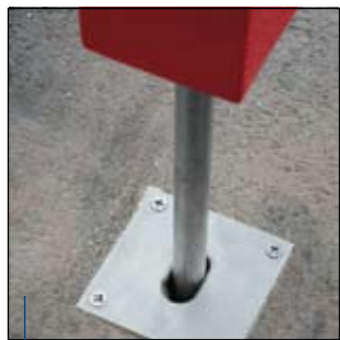
Bodenriegel mit Boden- platte aus Nirosta
