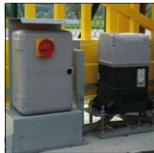
Antrieb mit verstellbarer Motorkonsole mit Schaltschrank und Hauptschalter
