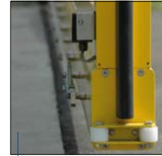
Torvorderkante mit Sicherheitskontaktleiste, Führungsrollen und Auswertegerät
