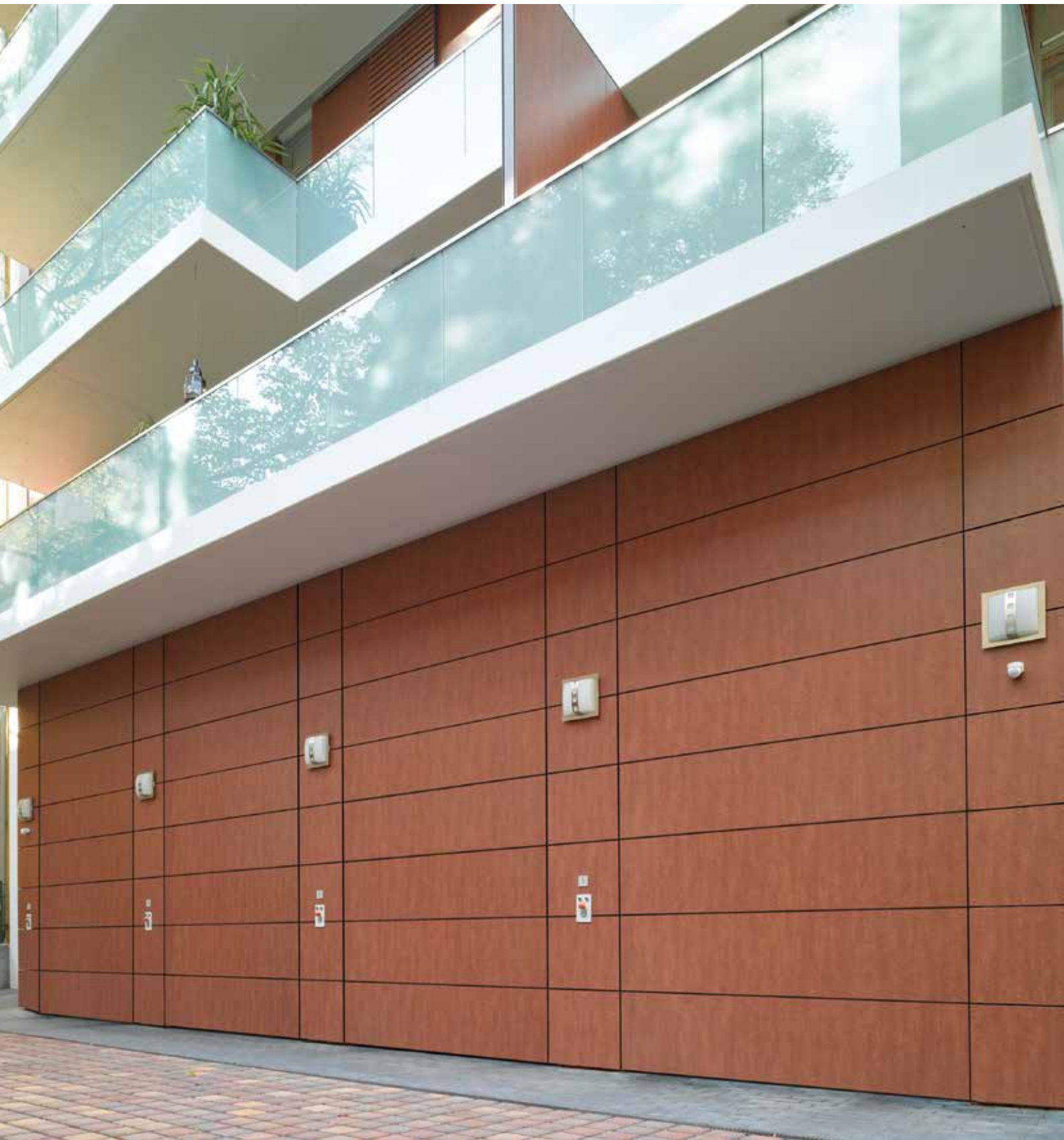
Bauseitige Beplankung mit Schichtpress-Holzplatten
