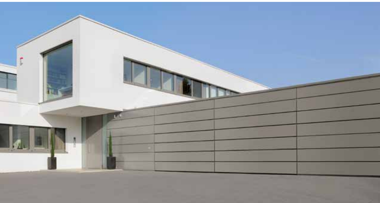
Bauseitige Beplankung mit Aluminium-Verbundplatten
