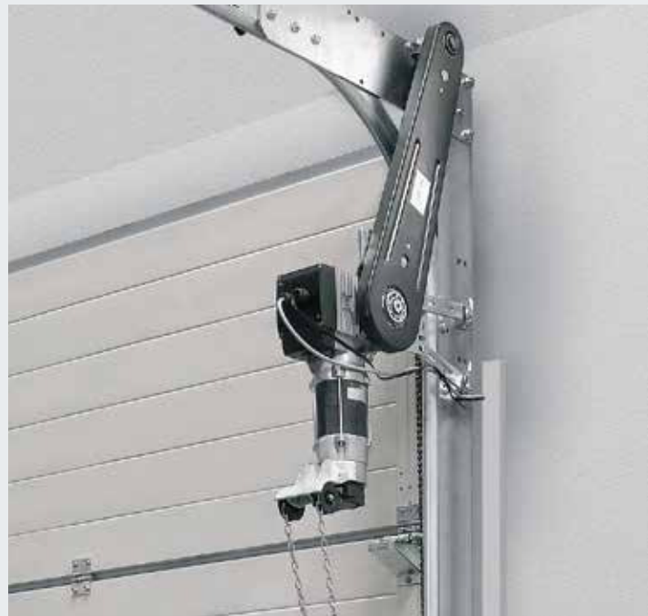
Standardeinbaulage senkrecht, Abbildung mit optionaler Not-Handkette
