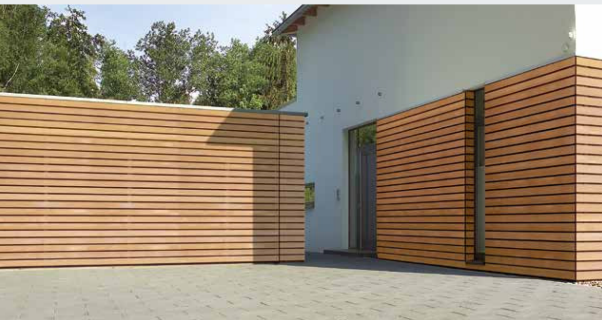
Bauseitige Beplankung mit Holzpaneelen
