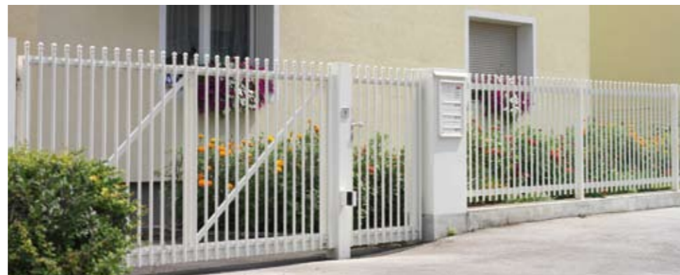
▲ 6 | Drehtor und Zaunanlage, Palisade gerade mit Rundkappen
