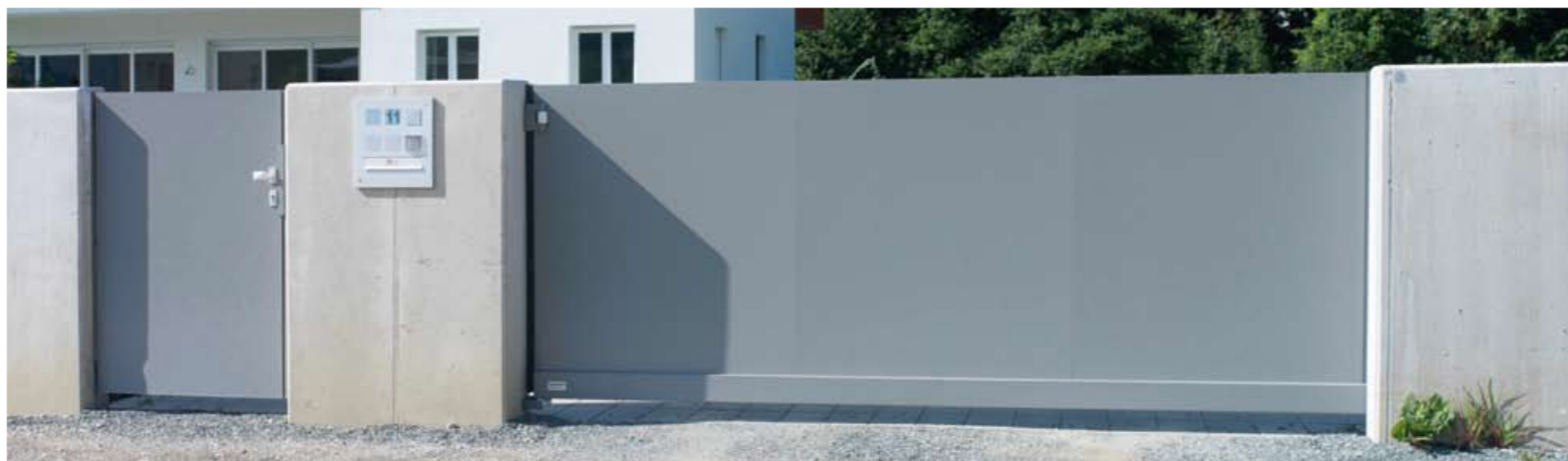
▲ 3 | Schiebetor und Gehtüre mit aufgeklebter Blechfüllung (Rahmen nicht sichtbar)
