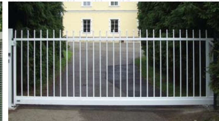
▲ 7 | Schiebetor mit durchgesteckten Rundstäben und Spitzkappen
