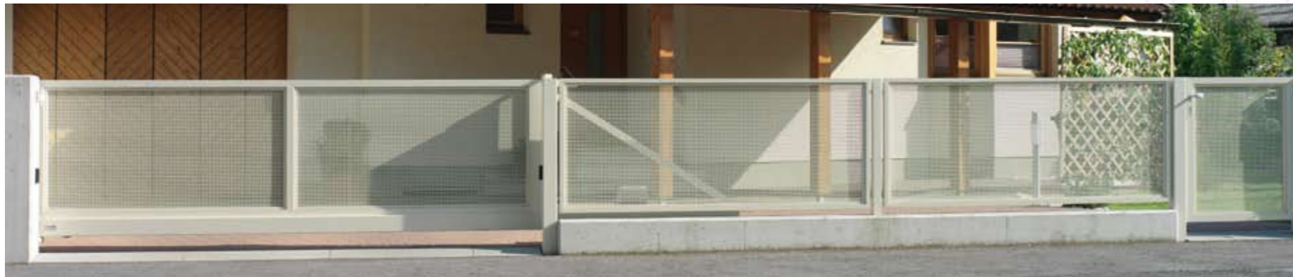
▲ 5 | Schiebetor, Zaunfelder und Gehüre, Lochblechfüllung mit Quadratlochung
