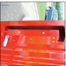
Bodenregel in Standflügel eingebaut
