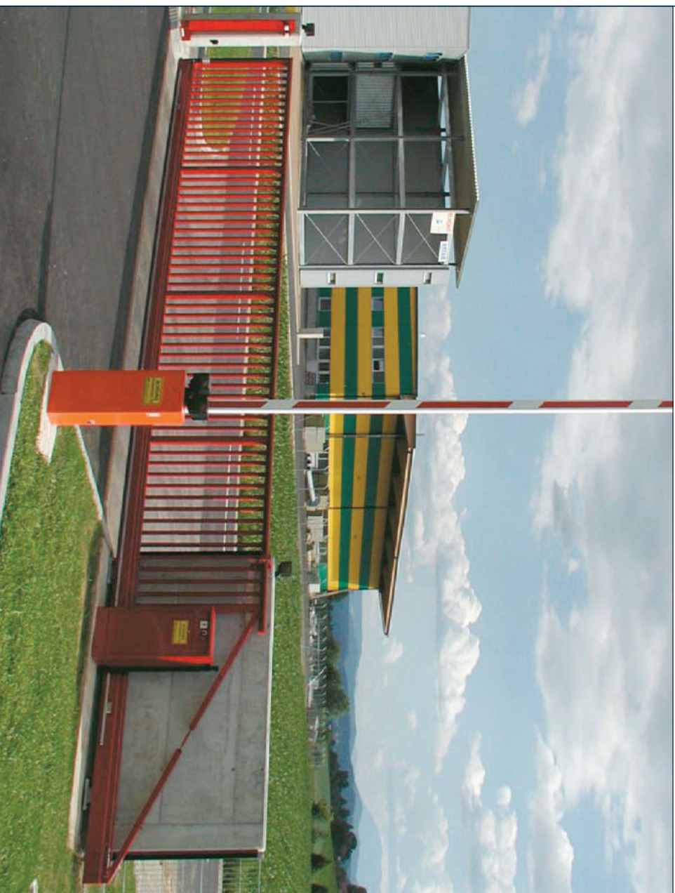
Antrieb mit verstellbarer Motorconsole mit Schaltschrank und Hauptschalter
