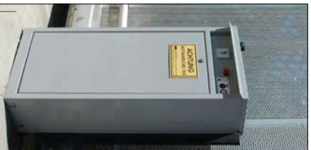
Antrieb mit verstellbarer Motorconsole mit Schaltschrank und Hauptschalter
